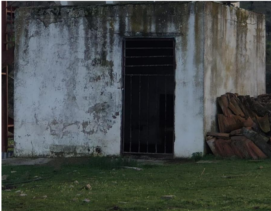
Caseta donde se aloja el pozo de sondeo.
